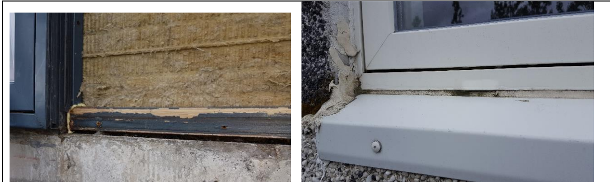
Mynd. Skipta þarf um skrúfur í öllum átrégluggum í skólanum þar sem skrúfur eru að hverfa vegna ryðs. Í A álmu er leki við lyftuhús.
