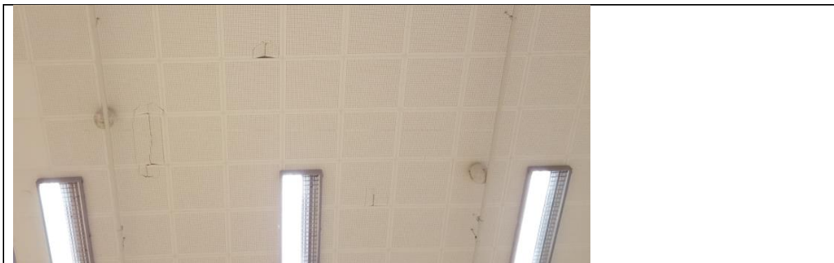
Mynd. Í íþróttasal þarf að skipta út loftplötum
