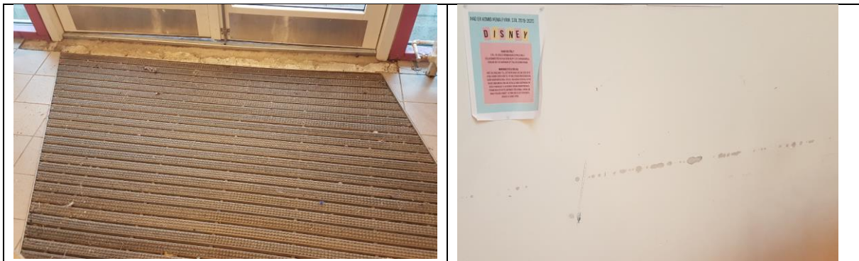
Mynd. Laga þarf gólfefni víða við innganga. Á mörgum stöðum innandyra þarf að mála vegg.
